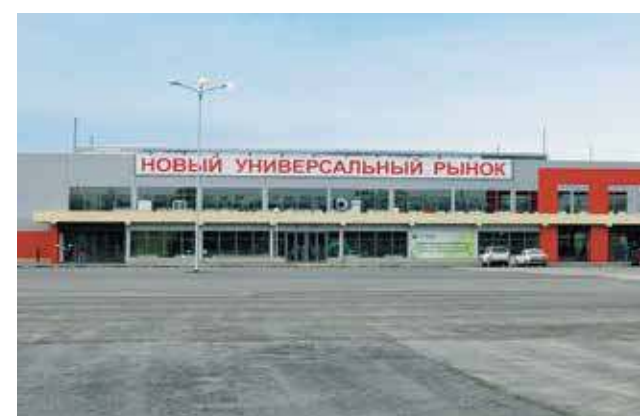
Муниципальный рынок, г. Рязань
