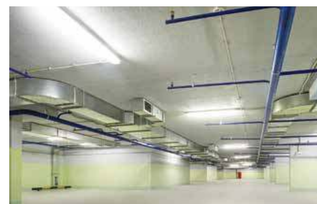
Подземная двухуровневая автостоянка, г. Королев
