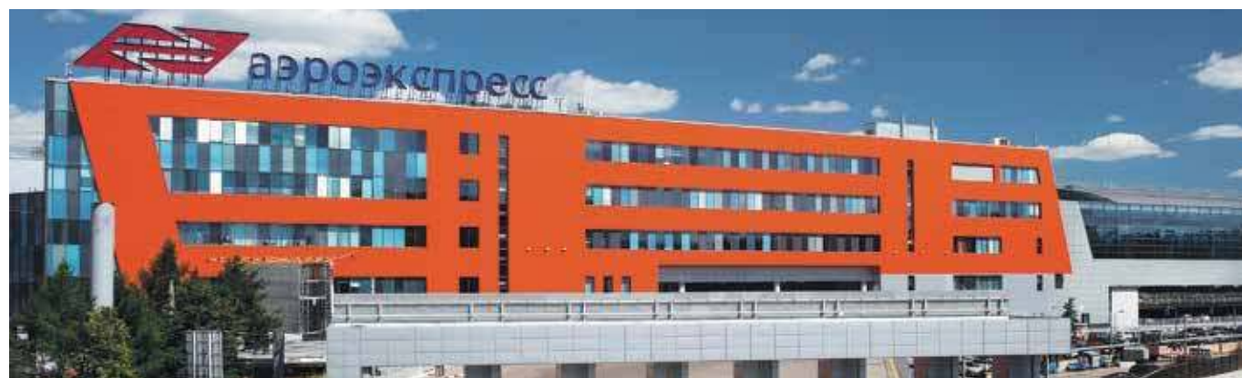
ООО «АЭРОЭКСПРЕСС», г. Химки
